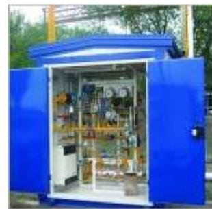
Для выполнения технологических процессов блоки включают в себя необходимый набор узлов и систем, размещаемых в отдельно стоящих блок-боксах или в сборных зданиях блочно-модульного типа (допускается выполнение в капитальных зданиях).
